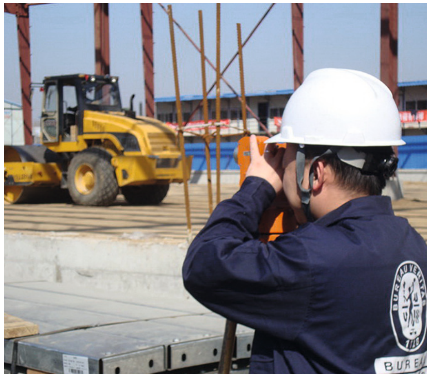
Contrôle d'un bâtiment en cours de construction en Chine.
