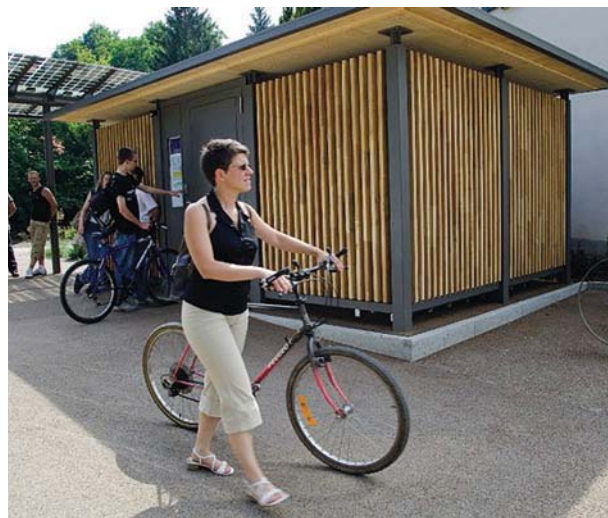
Labri à vélos de la halte écodurable de Niederbronn-les-Bains, en Alsace. La gare est construite avec une ossature bois.
